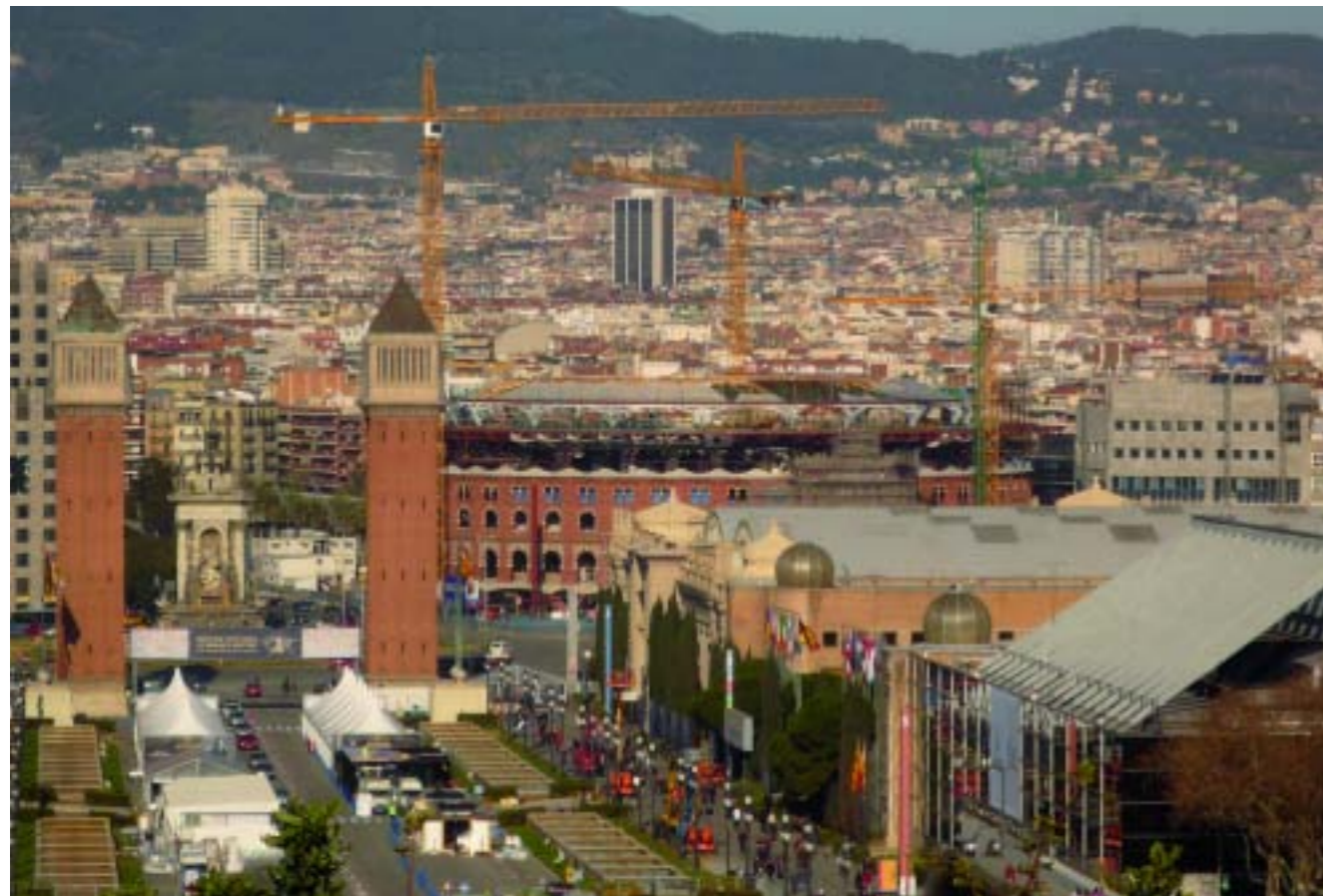
Aspecte actual que té l'obra del futur centre comercial
